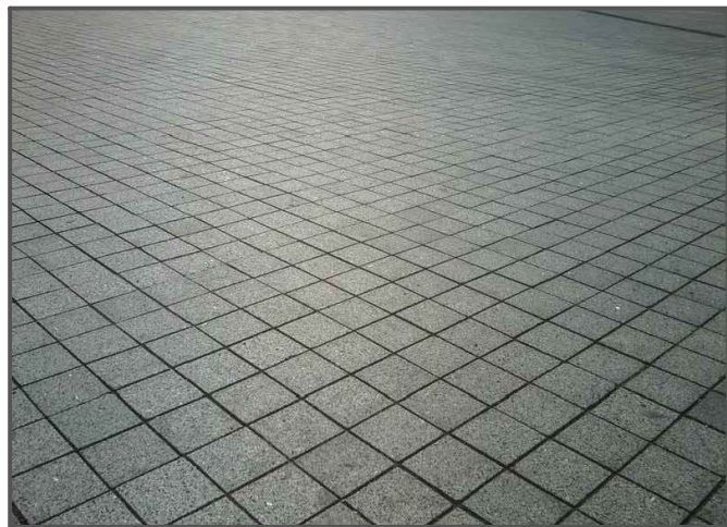
Тип 2а, 2. Брусчатка из гранита Каменногорский пиленая термообработанная 100*100*60, 100*100*80
