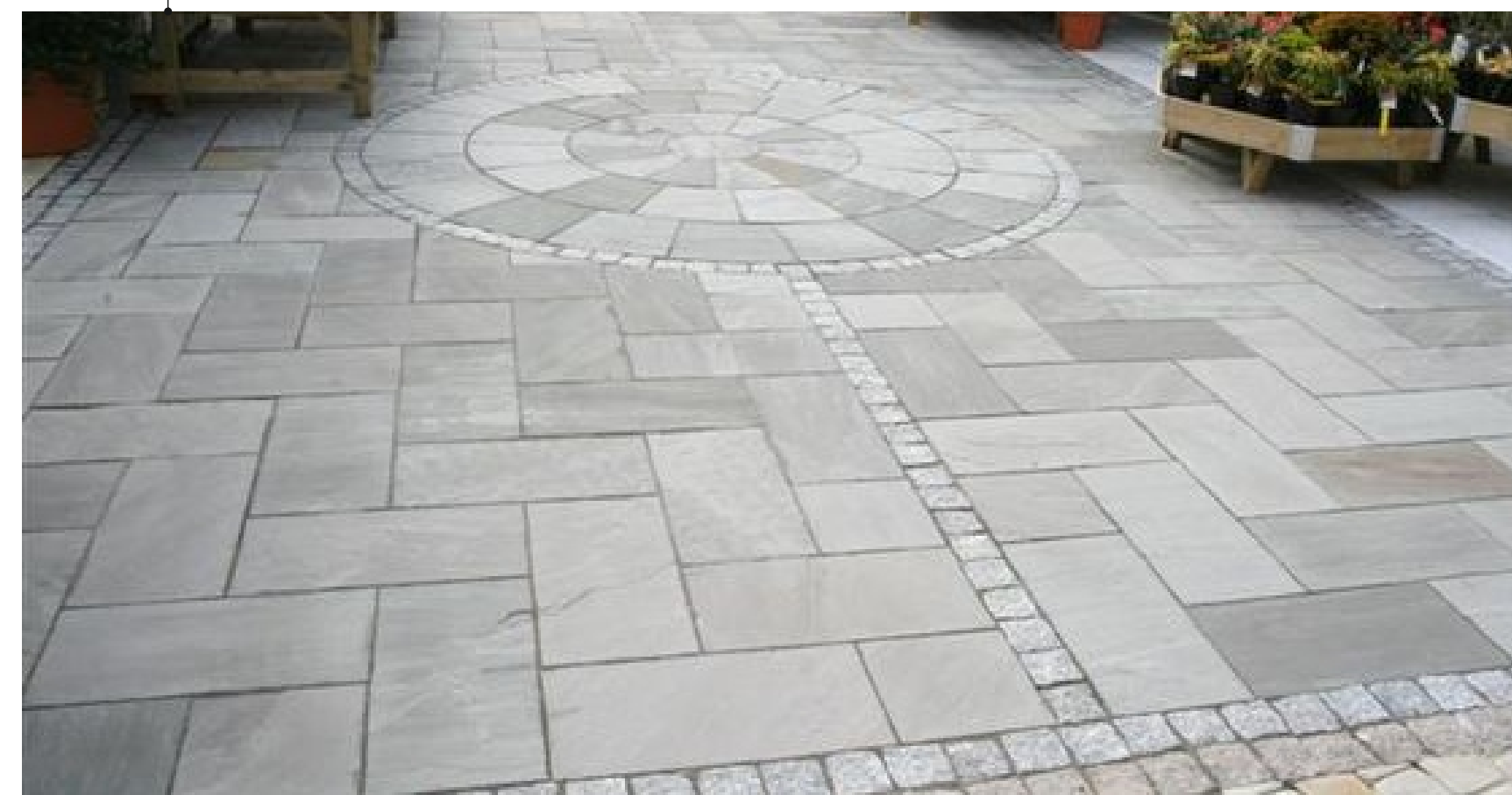
Мощение крупными гранитными плитами
