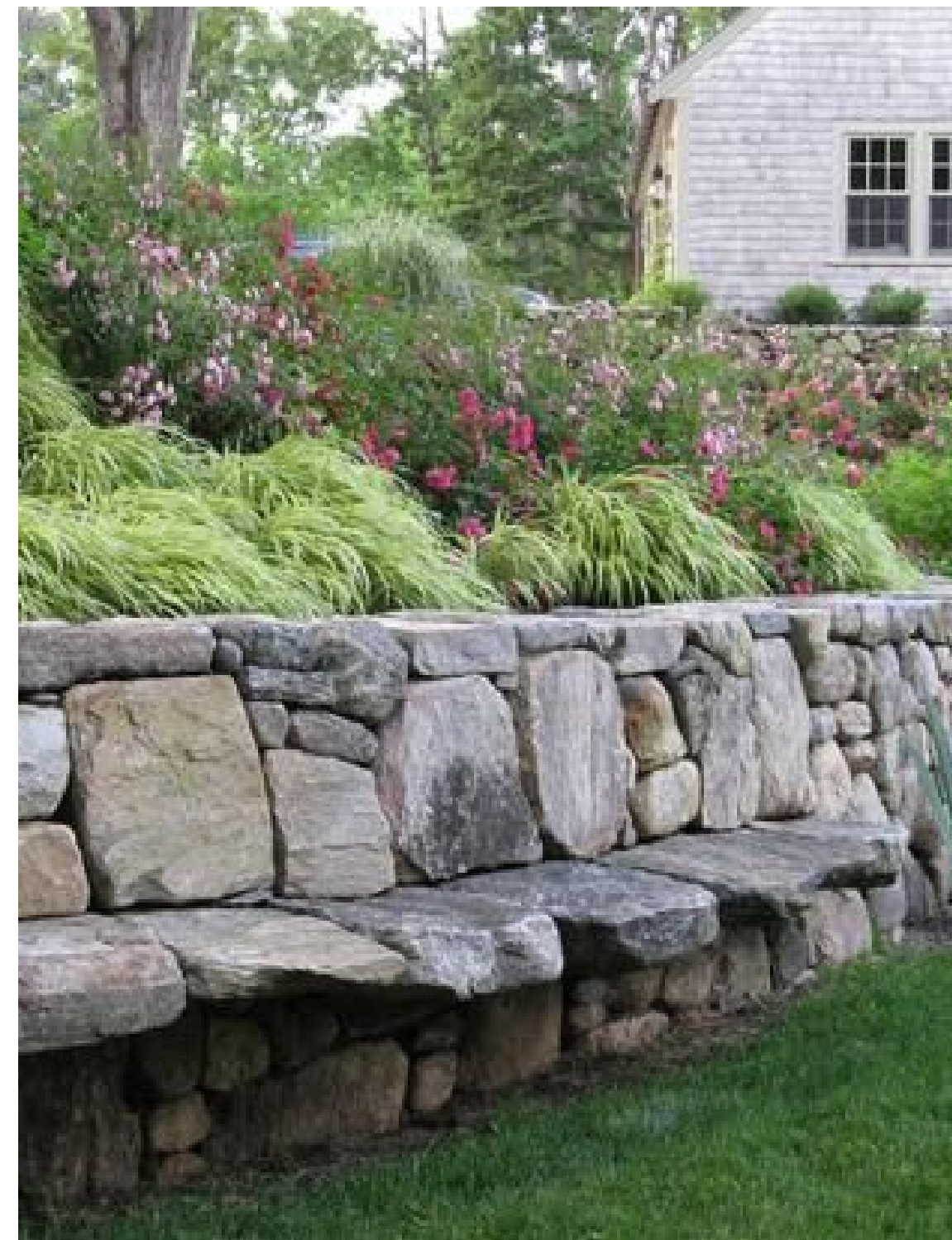
Подпорные стенки из гранитных блоков
