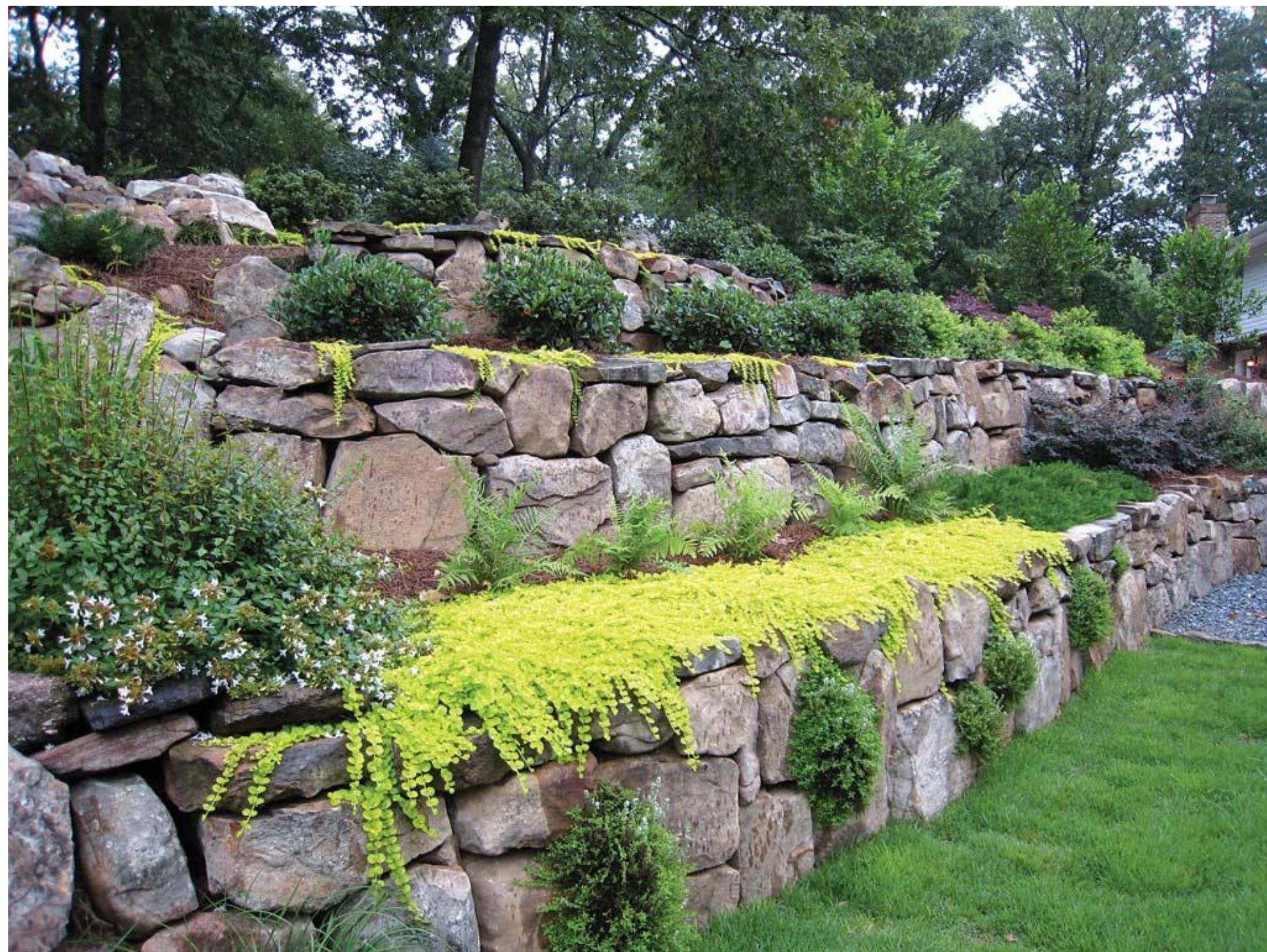
Подпорные стенки из гранитных блоков
