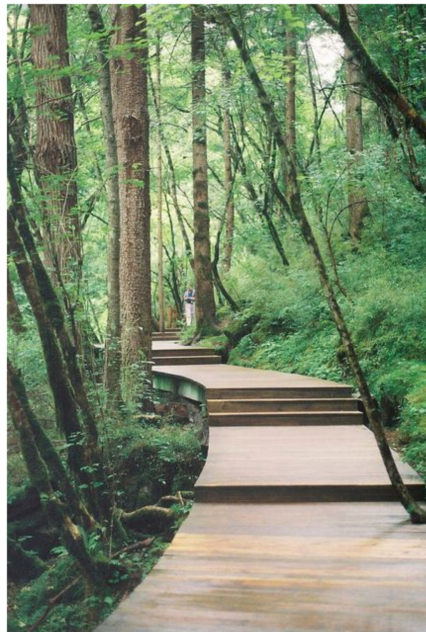
Деревянные мостки из термообработанной древесины Деревянные мостки
