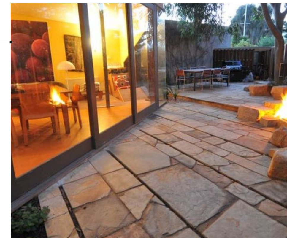
Мощение каменными плитами, уложенными по диагонали
