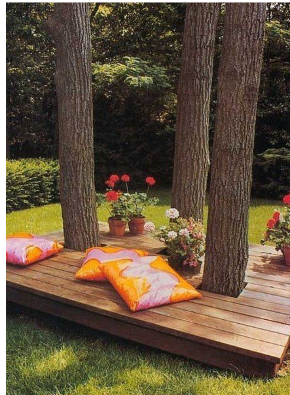
Отверстия для деревьев в мостках
