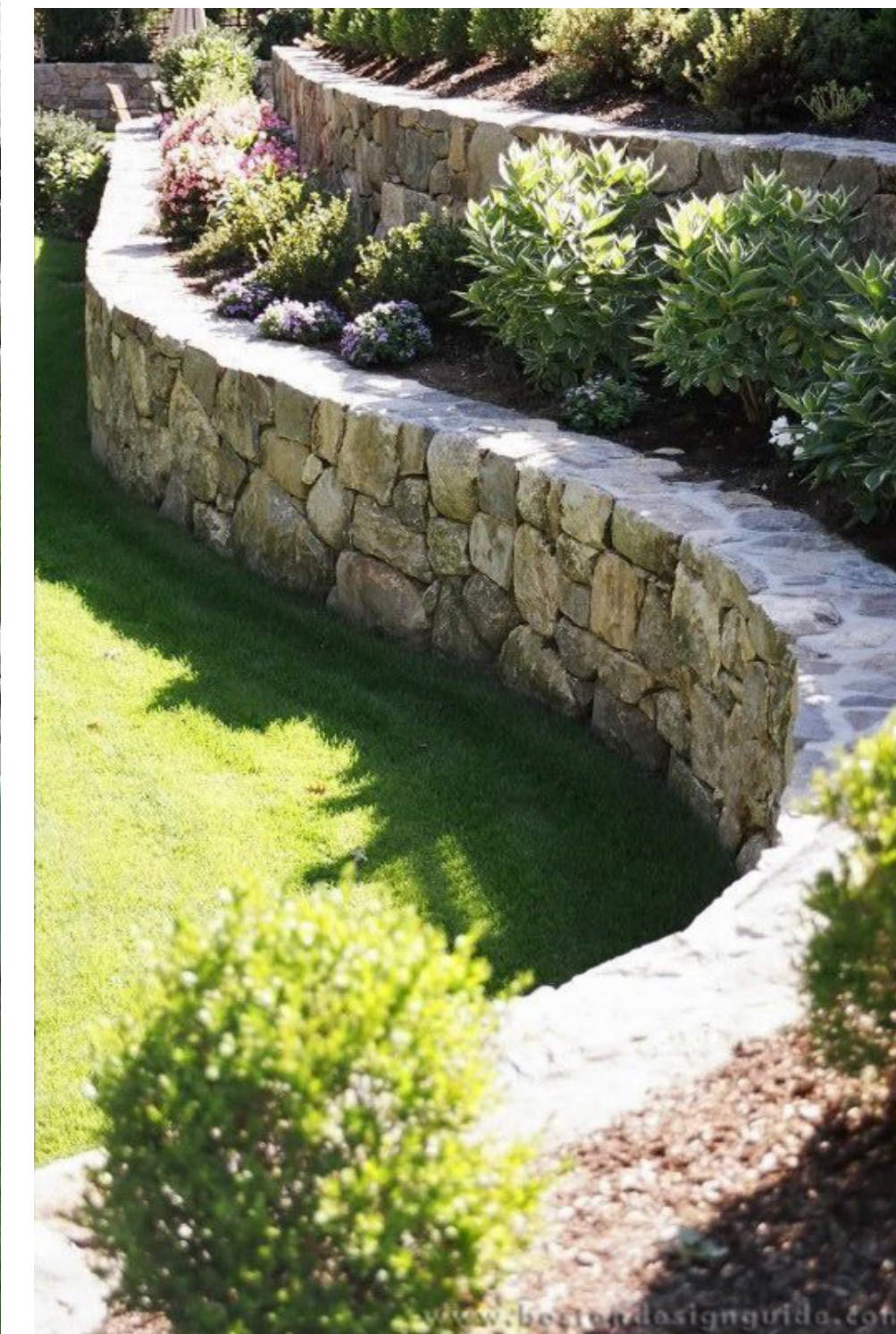
Изогнутая подпорная стенка
