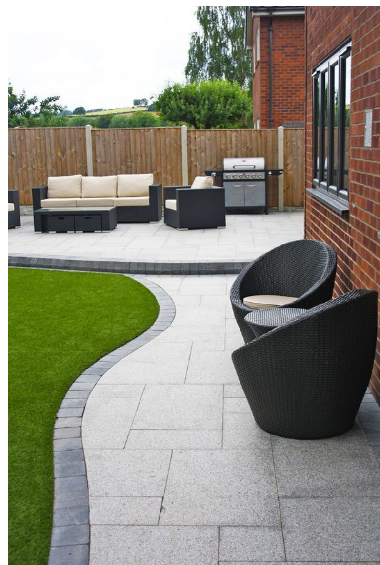
Мощение крупными гранитными плитами
